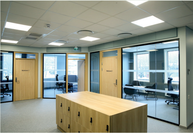
Fra kontorområdet til politiet. Her er systemglassvegger montert inn i plassbygde utsparinger, teppeflis på gulv, malt gips på vegger og systemhimling.
