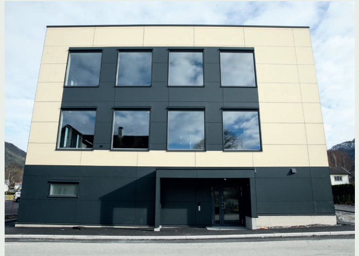
Vinduene med alu-beslag er produsert av Norgesvinduet Bjørlo, de er kortreist siden fabrikkken til vindusprodusenten ligger bare noen hundre meter bortenfor bygget.
