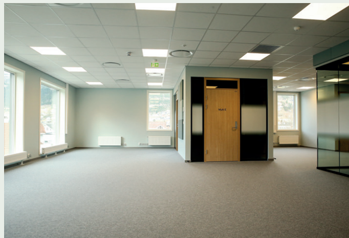
Fra 3. etasje i vestenden av bygget der Skatteetaten skal flytte inn. Vi ser her er teppeflis på gulv, systemhimling, malt gips på vegger og systemvegger som rominndeling.
