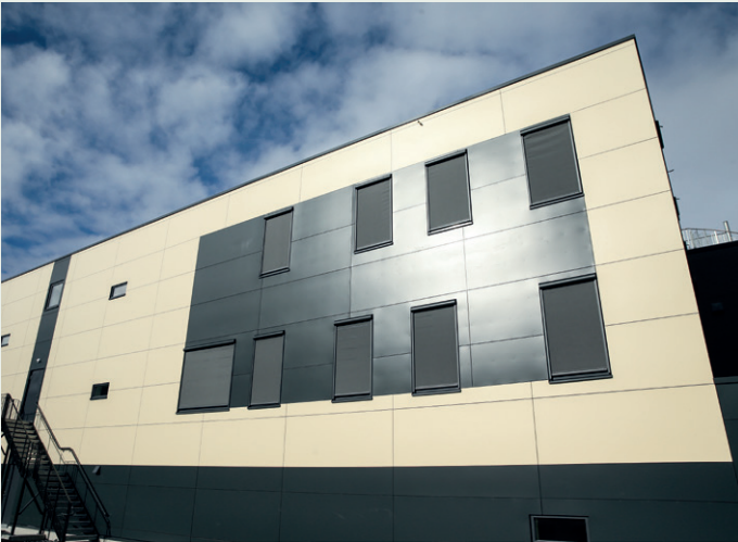
Statens hus har Rockpanel fasadeplater og solskjerming fra Norsol.
